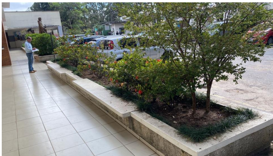
Reforma de todo canteiro
