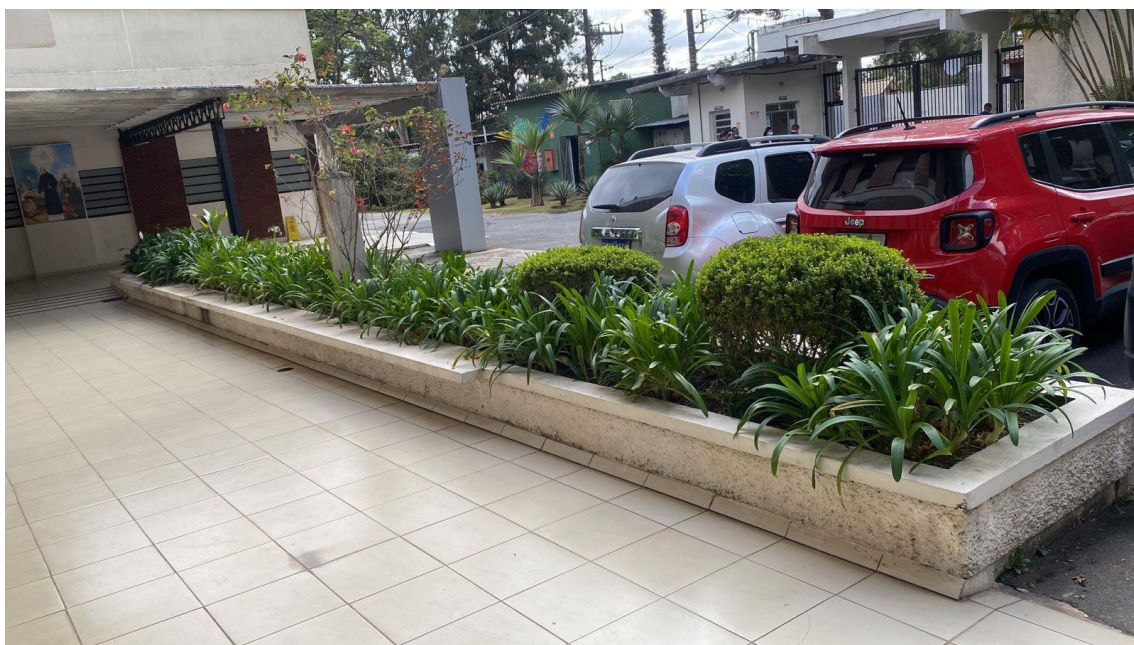
Reforma do Canteiro.
