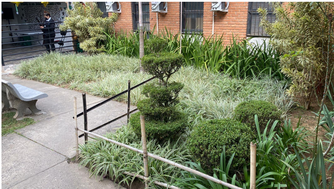
Reforma parcial de Canteiros.
